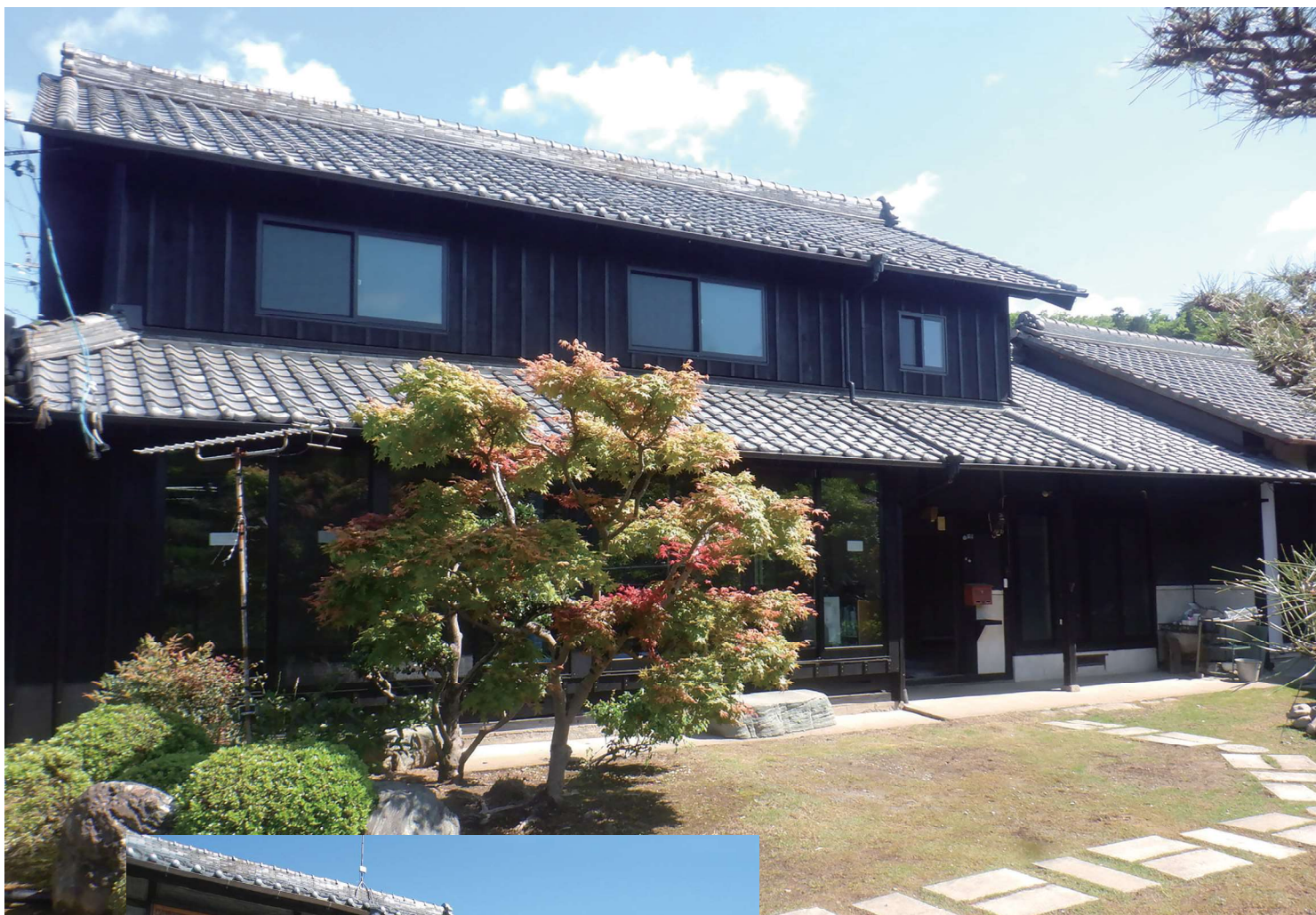
After 高気密サッシに取替え、壁に断熱材を入れ外壁に地元美山杉を張り美しい古民家に再生
