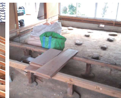
床組を取替えて畳からフローリングに張替
