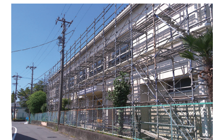
鶯小學校外壁落下防止工事
