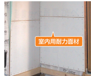
室内用耐力面材「かべ大将」にて補強
