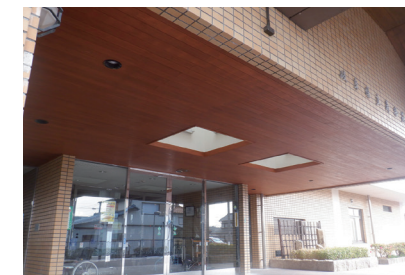
県立寿楽苑の玄関軒裏の木質化工事
