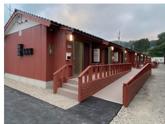
高齢者の多い地域のためバリアフリーに配慮した造り
