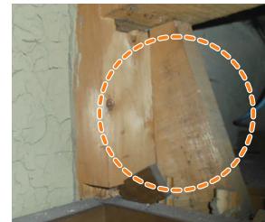
天井裏から筋交いを確認
