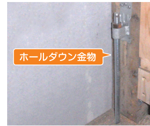
壁の強さに応じた金物を設置
