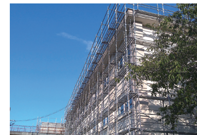
長森中学校外壁等落下防止及びその他工事
