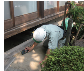
基礎の鉄筋の有無を金属探知機にて確認
